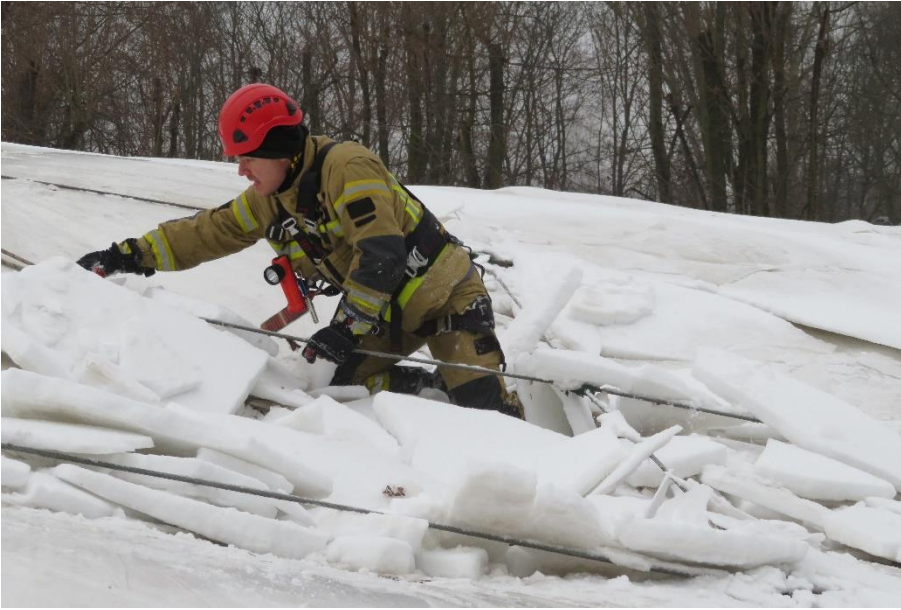
Rys. 11.24. Usunięcie nadmiaru śniegu i lodu z namiotu, Kraków ul. Bulwarowa - 10.02.2021 r.
