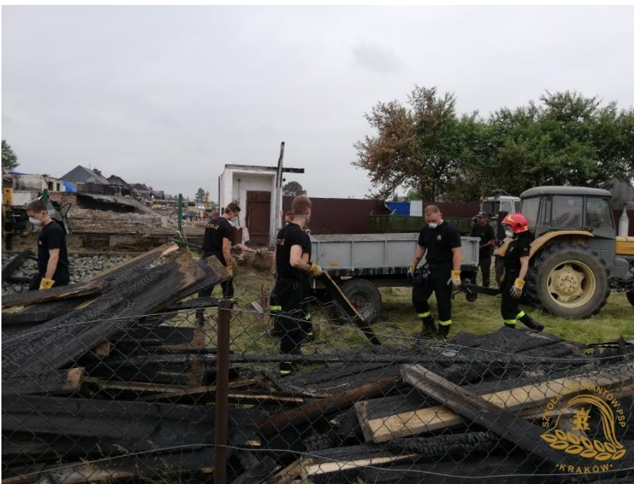
Rys. 7.13. Prace porządkowe i rozbiórkowe w m. Nowa Biała
