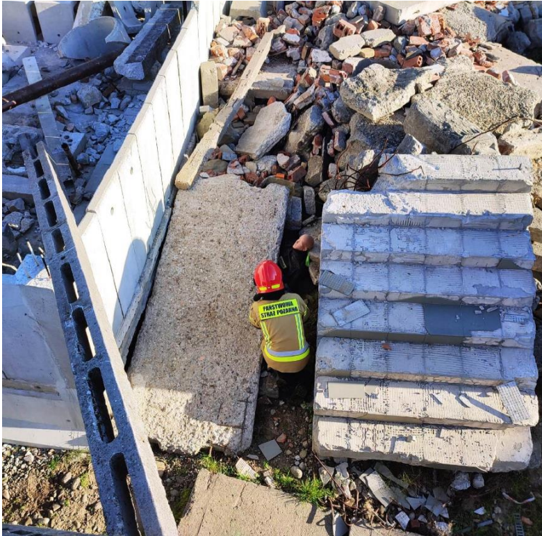
Rys. 4.2 Szkolenie specjalistyczne z zakresu organizacji działań poszukiwawczo-ratowniczych i technik ratowniczych w działaniach SGPR.
