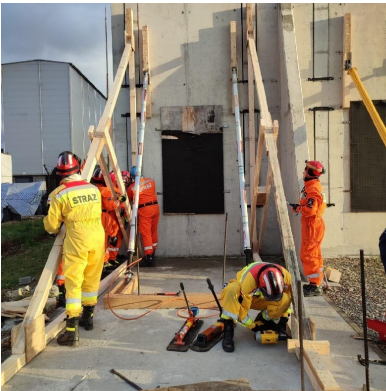
Rys. 4.1 Szkolenie specjalistyczne z zakresu stabilizacji naruszonych konstrukcji
